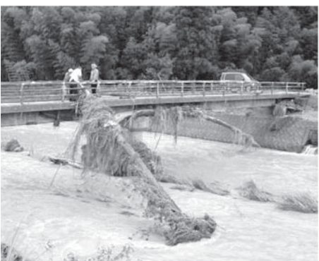
原田地区の齊宮橋。橋の高さを越える水が押し寄せ、床上浸水が多く発生しました。
